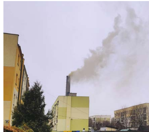
Dymiący komin kotłowni Spółdzielni Mieszkaniowej w Michałowie
